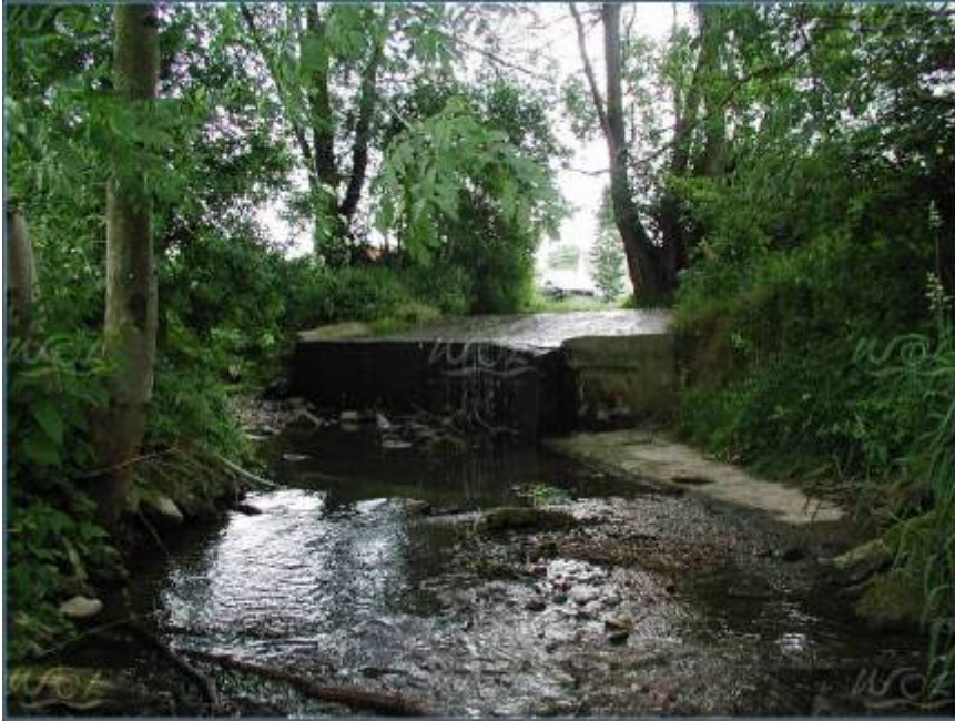
Ehemaliges unpassierbares Wehr in Husen. Wurde bereits umgebaut.
